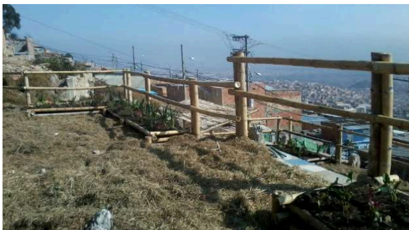
Figura 31. Espacio de observación pasiva con jardinera y baranda. Convenio 494 de 2014.
