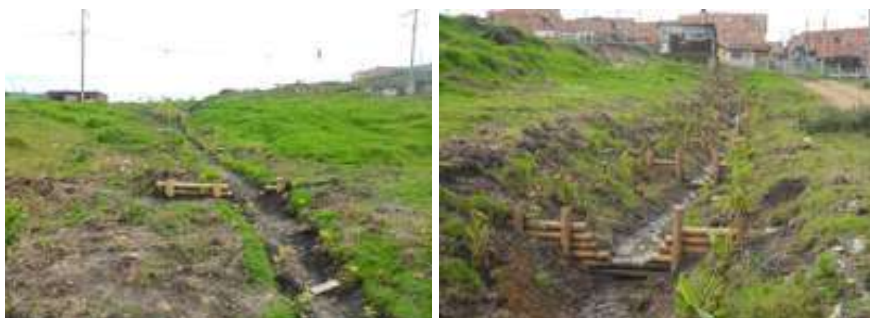
Figura 23. Filtro vivo con trinchos dissipadores en Altos de La Estancia. Convenio 587 de 2013.
