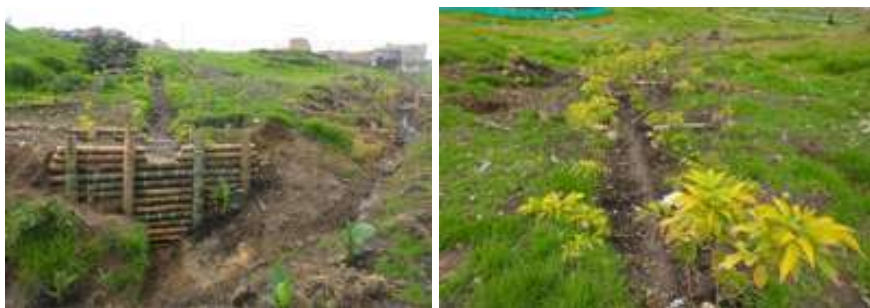
Figura 24. Filtro vivo con trinchos dissipadores en Altos de La Estancia. Convenio 587 de 2013.
