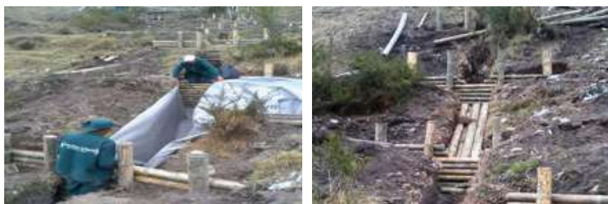
Figura 22. Construcción del filtro vivo en Cordillera Sur. Convenio 494 de 2014.
