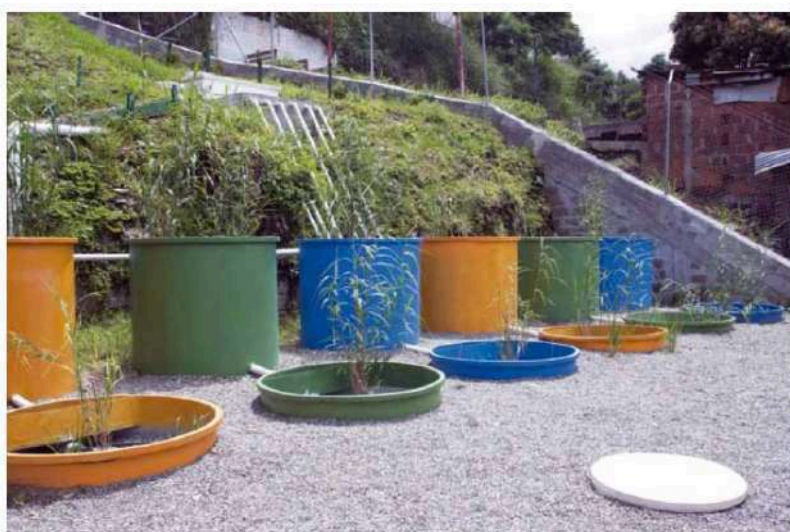
Figura 10. Ejecución planta piloto para el tratamiento de lixiviados. UNESCOsot, Colombia – TdeA.
